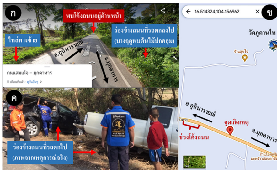
รูปที่ 3 สภาพแวดล้อมจุดเกิดเหตุ บนถนนทางหลวงหมายเลข 299 (สมเด็จ-มุกดาหาร) กิโลเมตรที่ 95+500 รูป ก & ข จาก Google map พิกัด 16.514324,104,156962 ถ่ายเดือนตุลาคม 2565 และรูป ค ถ่ายโดยทีมกู้ชีพ-กู้ภัยในวันเกิดเหตุ
