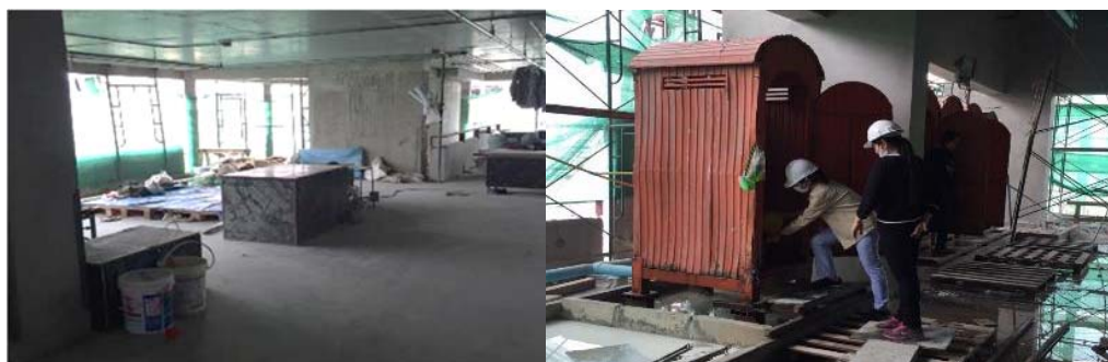
รูปที่ 3 สภาพแวดล้อมในแคมป์คนงานก่อสร้าง เขตสาธิต กรุงเทพมหานคร
